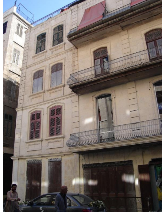
الصورة رقم (٤٢) مباني شارع النتل المجاورة لزقاق السيسي
